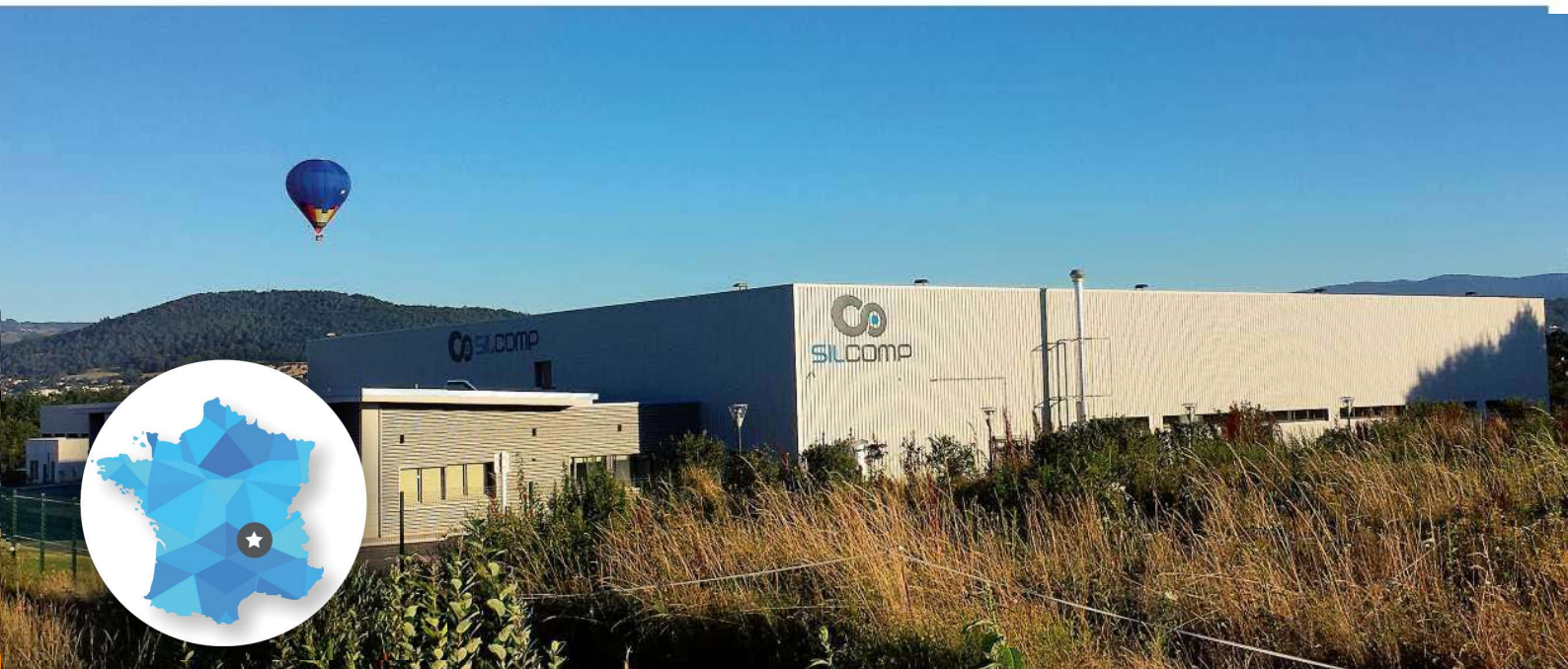
法国硅胶公司 阿诺奈 法国 SILCOMP France S.A.S., Annonay, France
